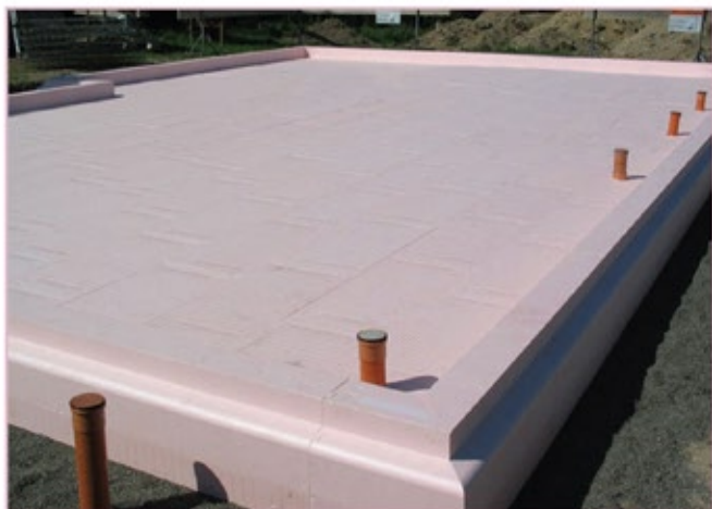
Εικ. 3 Μόνωση θεμελίων
