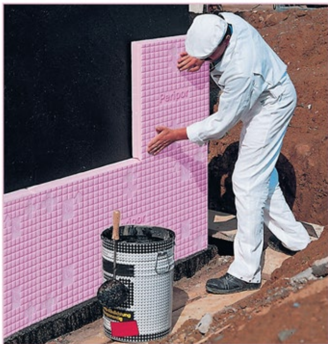
Εικ. 2 Μόνωση περιμετρικών υπόγειων τοιχείων
